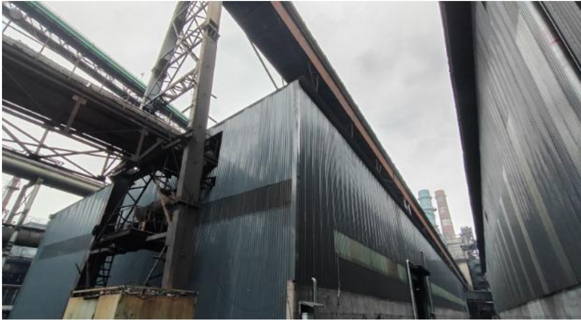
图：炼铁厂烧结煤场、喷煤池、精矿仓等堆场区域扬尘治理
