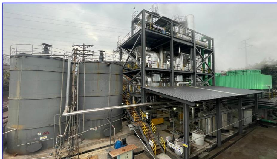
图 烧结机 38m<sup>3</sup>/h 脱硫废水综合处理利用项目
